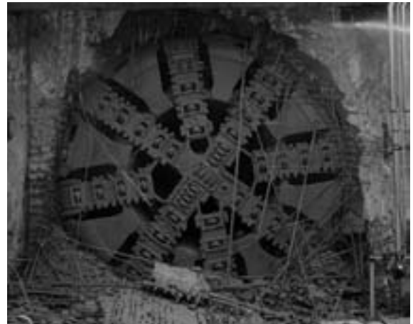
Soft Eye Bewehrung mit FIBERNOX® im Tunnelbau
