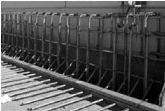
Brüstungsbewehrung mit FIBERNOX® - Bügeln bei einer Brücke
