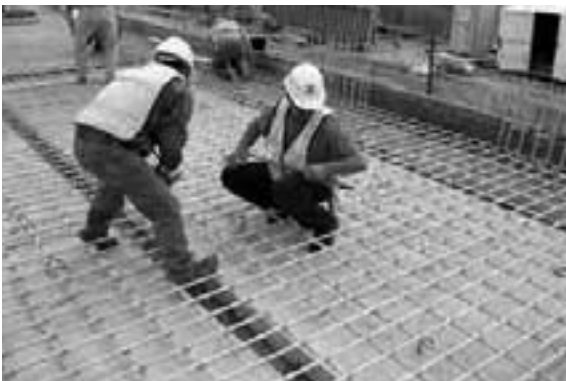
Flächenbewehrung mit FIBERNOX® - Rundstäben bei einer Bodenplatte
