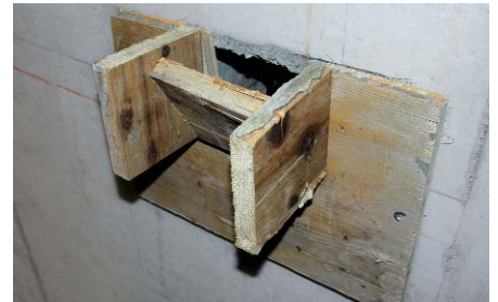
Mise en place des appuis HQW et des boîtiers insonorisants dans l'élément préfabriqué par le biais d'évidements dans le mur, puis réalisation du coffrage et remplissage des évidements avec du béton
