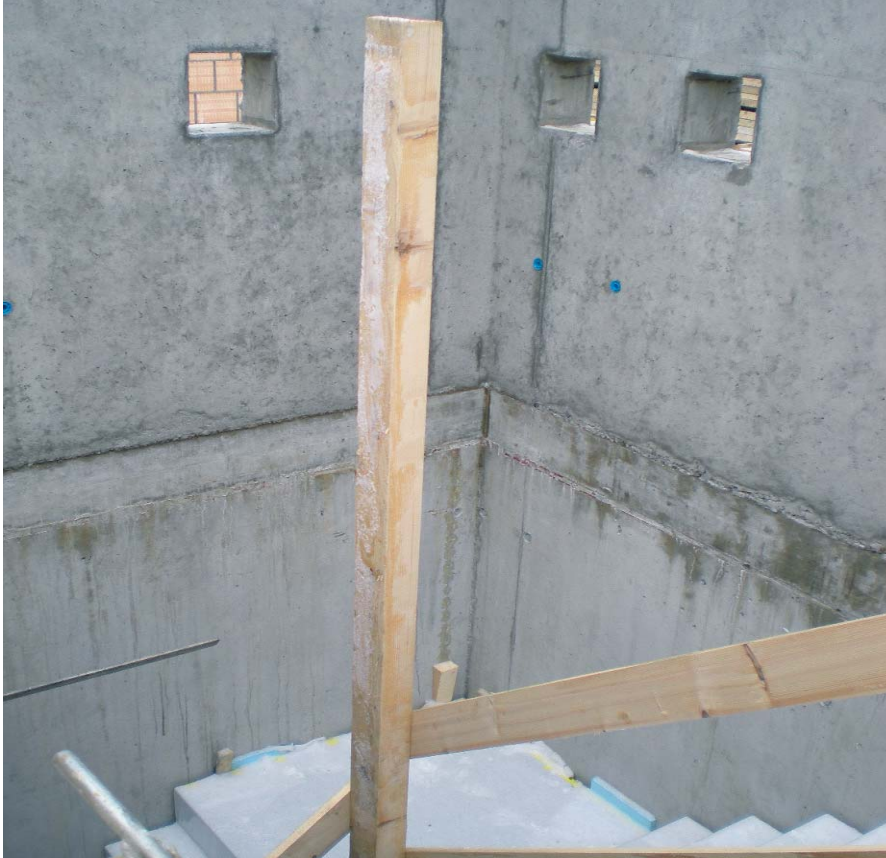
Einbau der HQW Dorne und Schallboxen in das in der richtigen Position gesicherte Fertigteil via Wandaussparungen, danach Abschaltung und Ausbetonieren der Aussparungen
