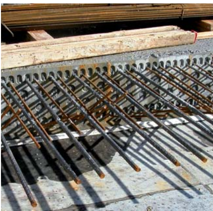
Wandabschalung mit Zembord Coffrage de mur avec Zembord
