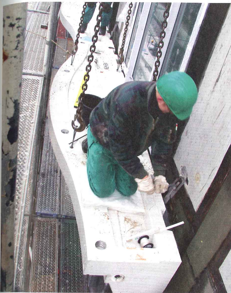
Abb. 1: Spezielle Betonfassadenbefestigung an einer Hotel-Fassade.
