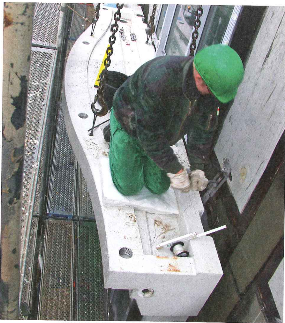
Sicherer Halt: spezielle Betonfassadenbefestigung an einer Hotelfassade
