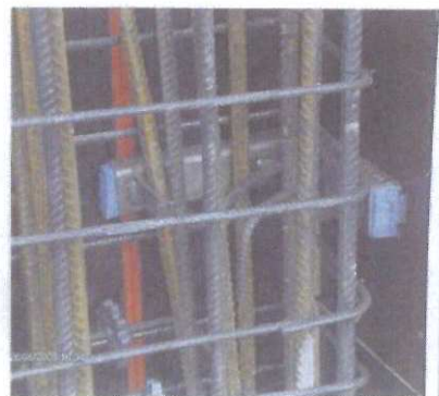
Bild 2. Ankerschienen wurden bei den Stahlbetonstützen in die Bewehrung eingebaut
