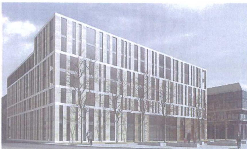
Bild 1. Fassade der Mannheimer Abendakademie: Fertigbetonelemente aus Weißzement und Sandsteinmauerwerk symbolisieren ein Bücherbord (Foto: Johannes Vogt)
