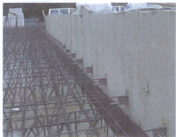
Bild 5. Die Doppelschubdorne der DKG werden direkt in die Bewehrung eingebaut; in den Tiefgaragen werden zur Erreichung der Klassifizierung F90 zusätzlich JORDAHL®-Brandschutzmanschetten eingesetzt (Fotos 4 und 5: HTG Hoch- und Tiefbau Gadebusch GmbH, Selbmann)
