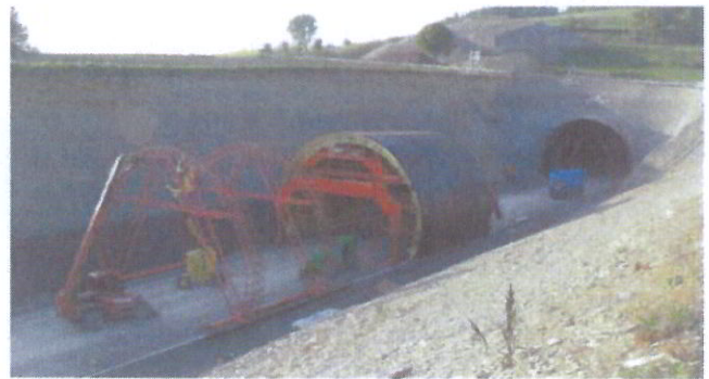
Bild 2. Der als zweischaliges Bauwerk entstehende Bleßbergtunnel wurde mit JORDAHL® Ankerschienen JTA W53/34 in Edelstahl ausgestattet – ein spezieller Schalwagen dient dem Einbau der inneren Tunnelschale (Bilder 1, 2: DB AG)
